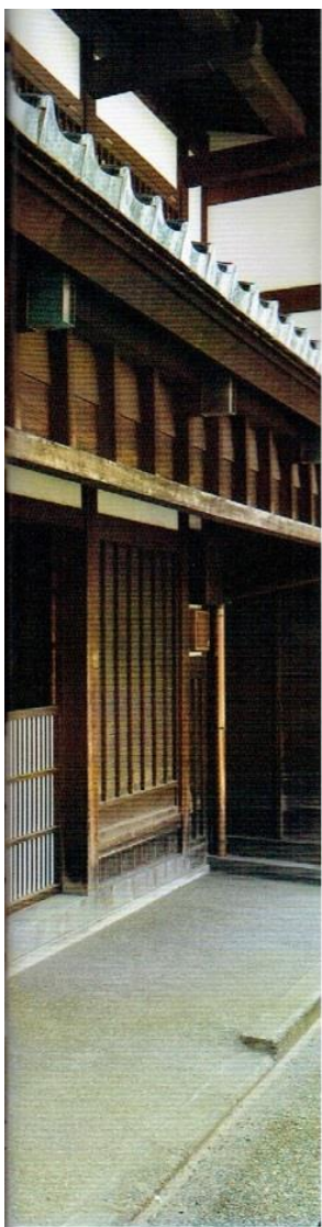
サガリは雨風が吹き込むのを防ぐために横に長く取り付けられた板。機能性に加え、曲線の優美な印象も与える。部戸は一階のシャッターのような役割があり、2枚の木の板を上にもすり上げれば、全て開くことができる。夏の日中は下段に障子のみをはめる。(暁 立野)
