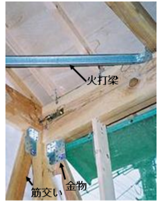
写真1 伝統構法(左)と在来工法(右)の接合部
