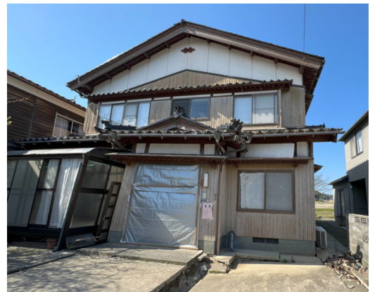
写真6 在来工法の建物の被災例(珠洲市正院)
