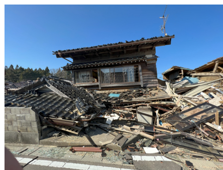
写真4 倒壊した家屋（珠洲市蛸島）
