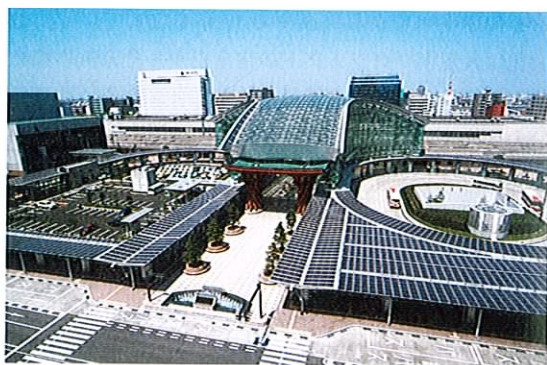
■写真2 金沢駅東広場とガラスの大屋根（金沢市提供）
