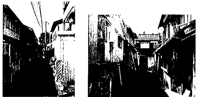
図12 事例地区の現況
