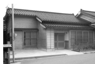
写真4 能登ふる事業を活用して補修された住宅
