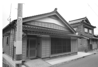
写真3 能登ふる事業を活用して新築された住宅
